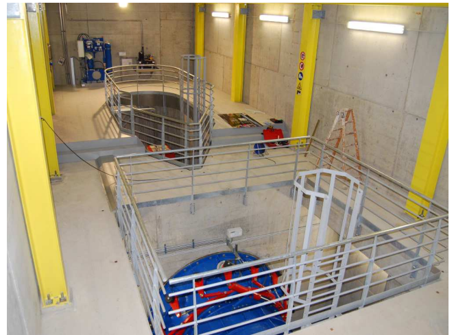
Fertig installierte Turbine Installed Turbine
