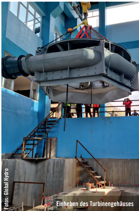
Im Kraftwerk Chepe Kola in Nepal wurden die ersten marktreifen EVO-Peltonturbinen installiert.
