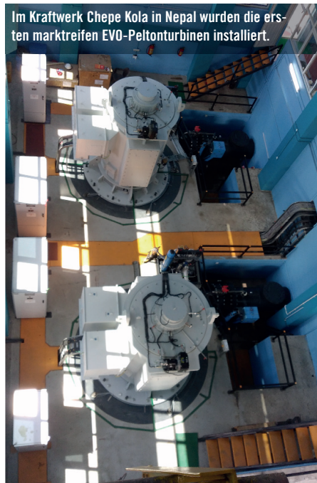
Einheben des Turbinengehäuses
