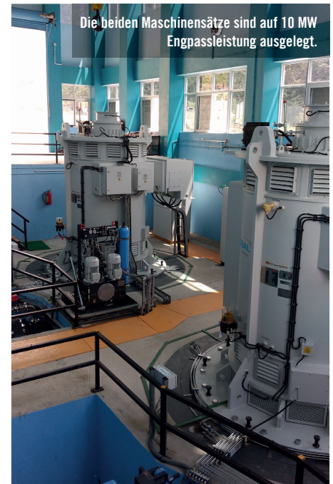
Im Kraftwerk Chepe Kola in Nepal wurden die ersten marktreifen EVO-Peltonturbinen installiert.
